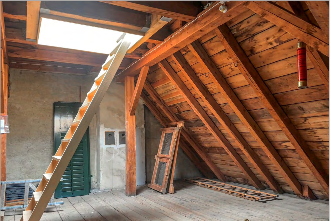
Dachgeschoss mit Ausgang zur Zinne
